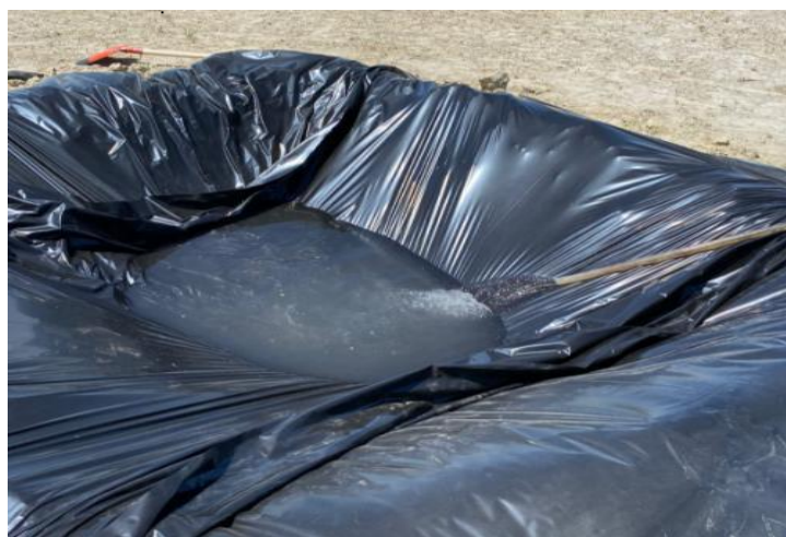
Рисунок 18 - Открытая испарительная площадка с недренированным дном
