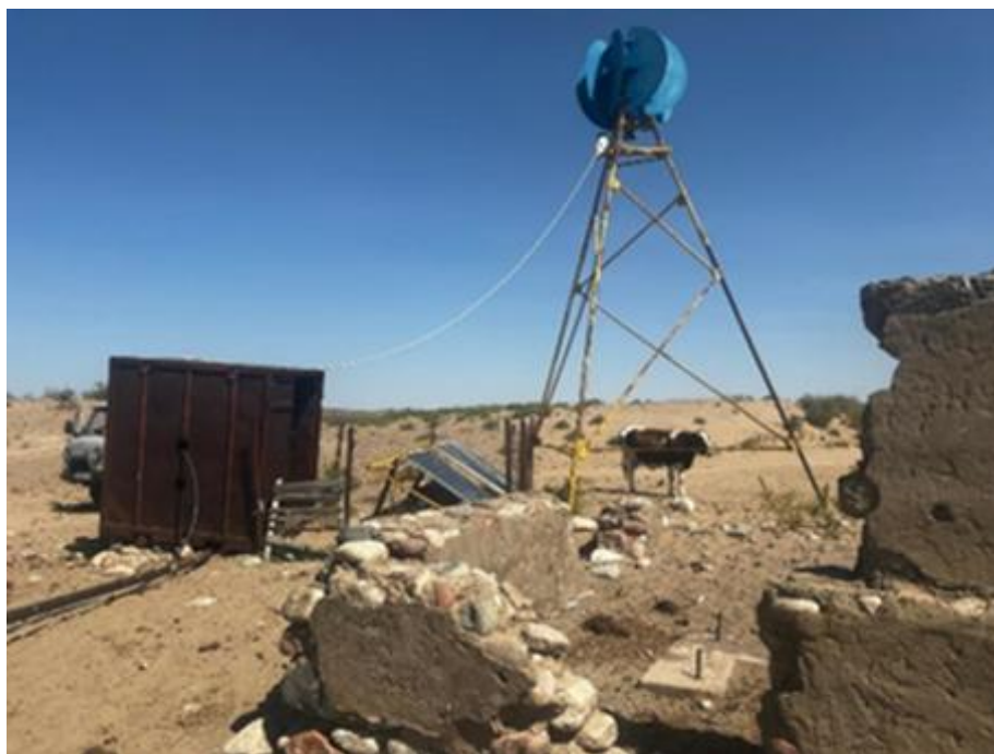
Рисунок 11 - Водозаборные сооружения крестьянского хозяйства «Касанхан»
