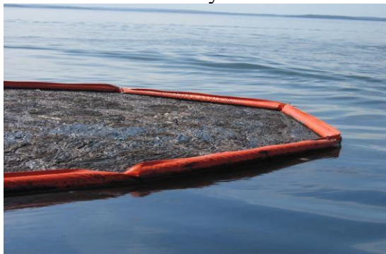
3-сурет. Мұнайды бумдар арқылы оқшаулау процесі
