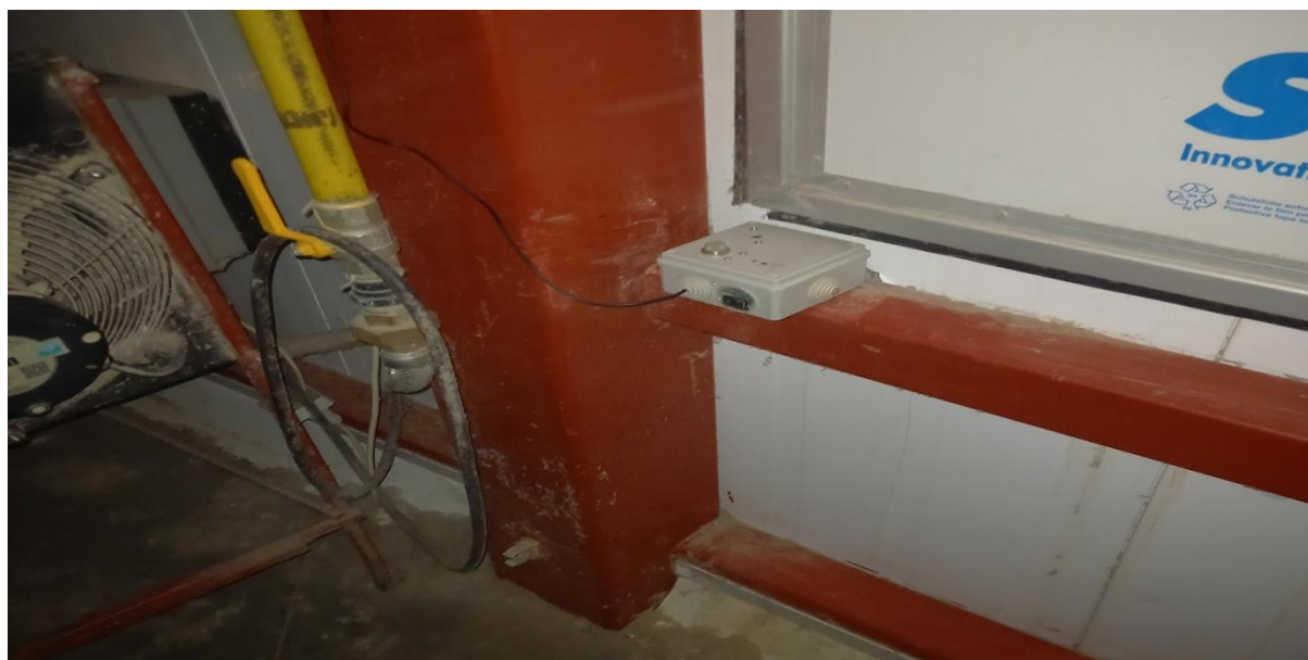
Рисунок 1 – Установка в цеху птицефабрики цифрового интеллектуального прибора для контроля климатических параметров
